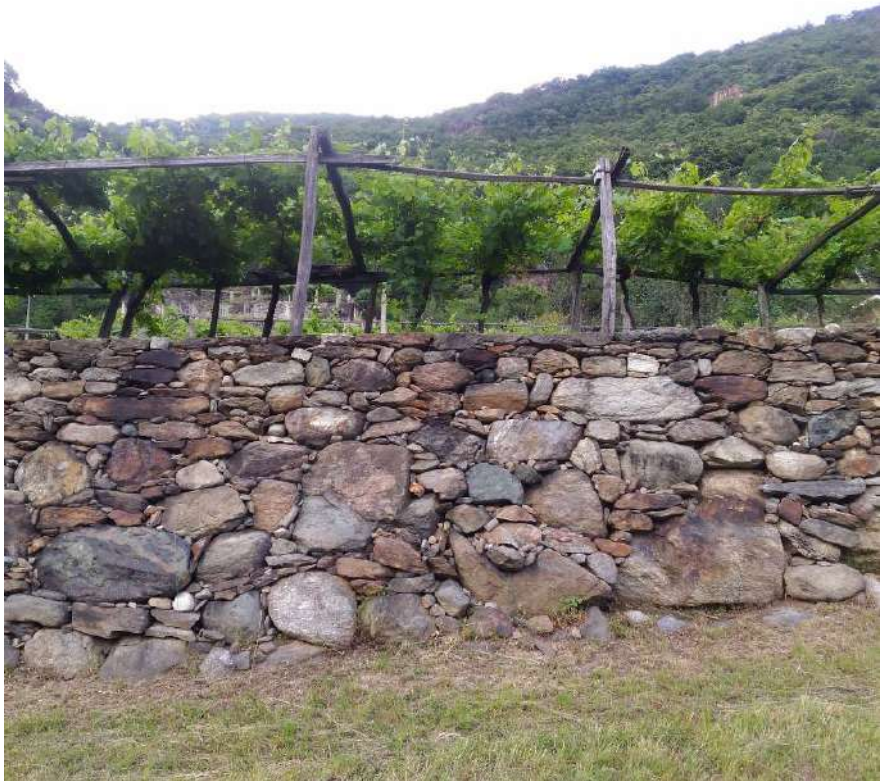
Prospetto tipo di muro in pietra a secco. Si notano massi di grande pezzatura posti alla base, pietre di media dimensione a costituire il paramento esterno e scaglie più piccole poste a riempimento definitivo degli spazi. Il colmo del muro è realizzato con pietre con una faccia piatta o livellata posta verso l'alto, in modo da agevolare il deflusso delle acque e fornire spazio calpestabile. I pali verticali in legno a sostegno della pergola sono piantati nel terrapieno sostenuto dal muro, subito dietro la copertina. La grande massa di pietra costituita da simili manufatti svolge il ruolo non secondario di accumulo di calore durante il giorno e rilascio nel corso della notte, creando un microclima particolare e favorevole alla maturazione delle uve.
