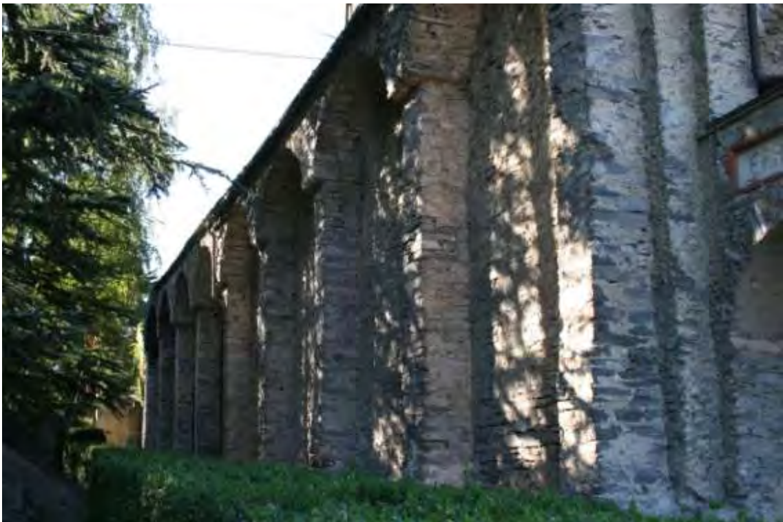
Foto 6, 7 - La cortina sud-occidentale, segnata dalle lesene che reggono, su arcate, il cammino di ronda.
