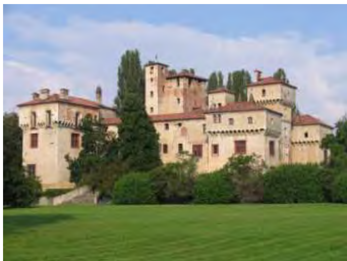
Foto 3 - Prospetto sud dal giardino del castello
