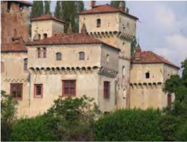
Foto 5 - Torre d'angolo sud est
