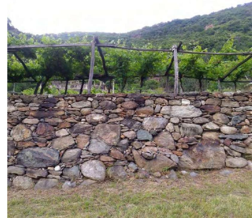
Prospetto tipo di muro in pietra a secco.
