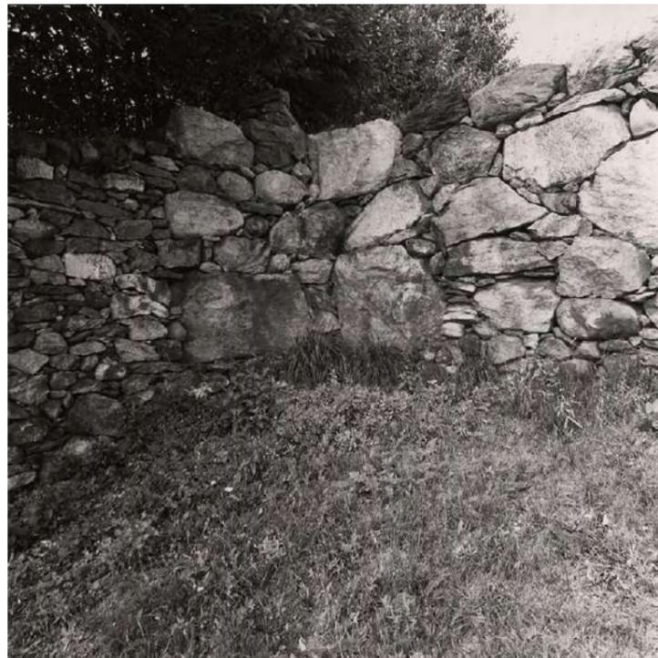
Si nota l'angolazione accentuata del profilo del muro verso monte, volutamente realizzata per contrastare la spinta del terrapieno contenuto dal muro.
