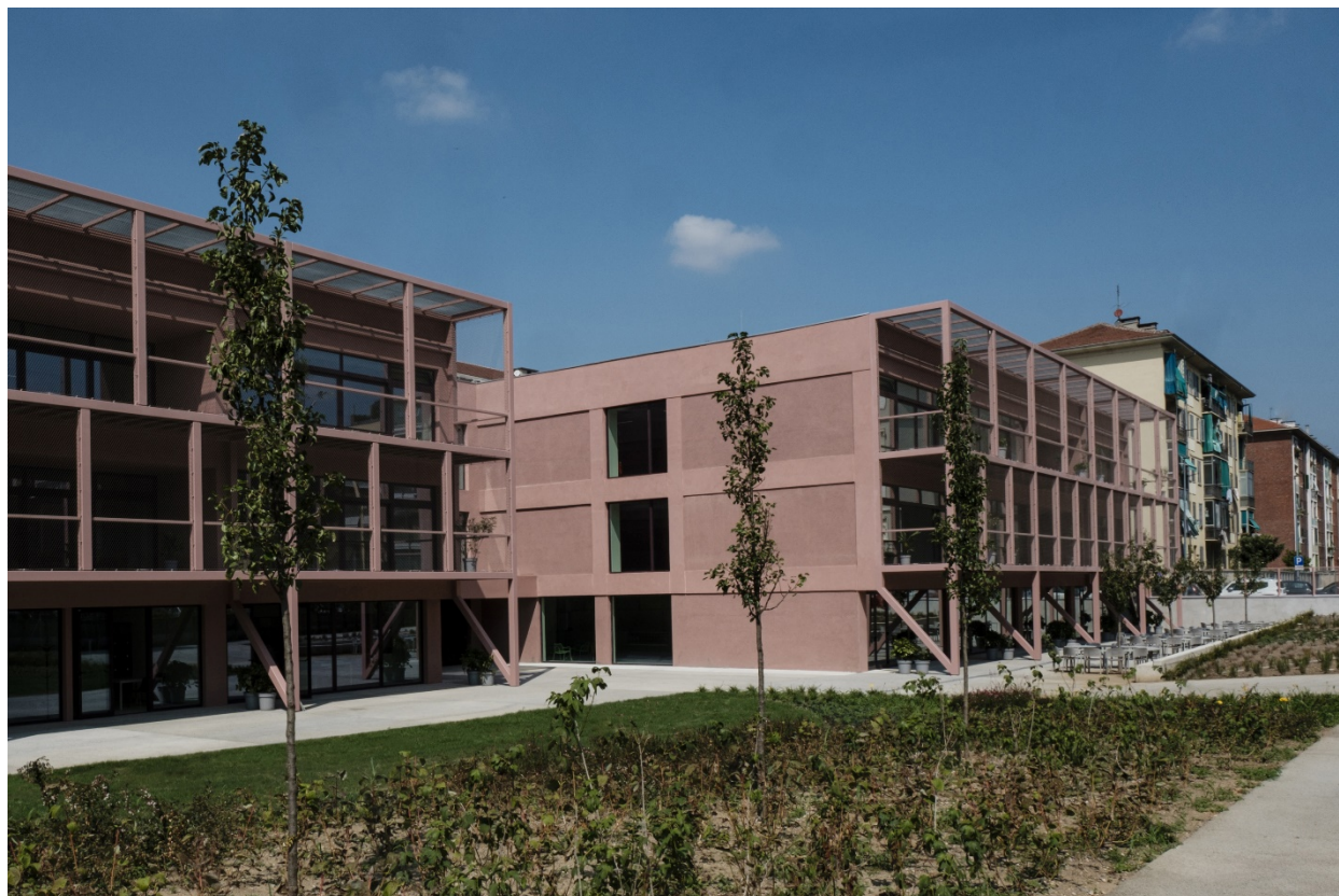
Scuola Fermi – La nuova facciata e il giardino (foto Andrea Guermani)
